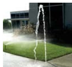
X-Flow nélkül 3 bar nyomáson fúvóka nélkül kb. 160 l/perc vízmennyiséget pazarol el az 570Z szórófej
